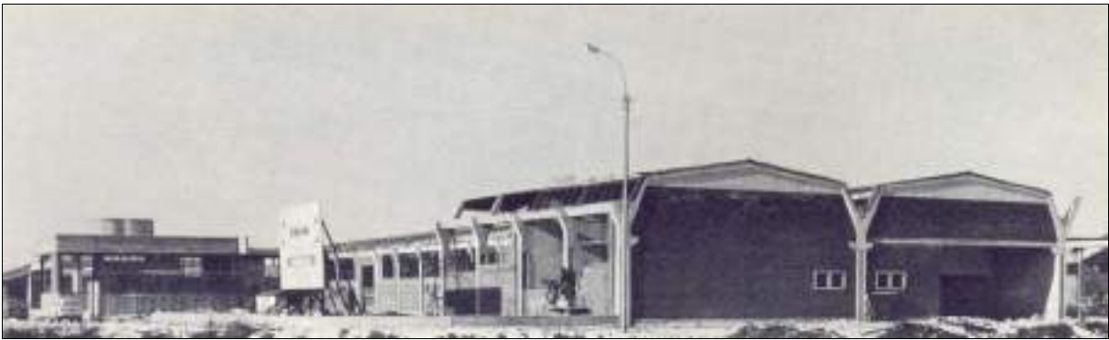
Stabilimento tipo Vittoria per il Grissificio Zingonia in corso di costruzione
