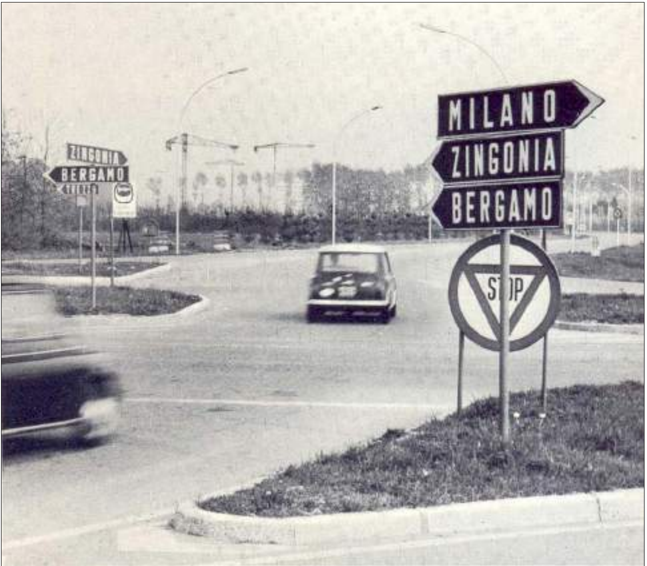
Raccordo stradale mediante il quale il Corso Europa, arteria di attraversamento veloce di Zingonia, si innesta nella provinciale Milano-Bergamo
