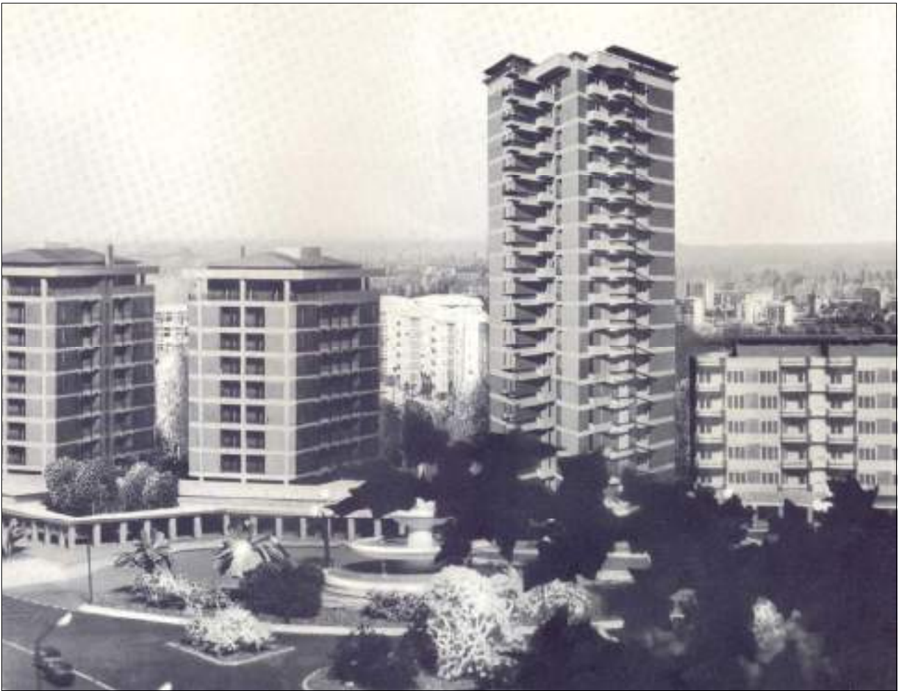
Piazza degli Affari a completamento dei lavori
