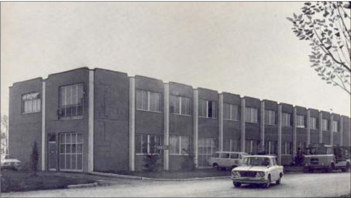
Stabilimento tipo Napoli: l'esterno di una fabbrica di prodotti alimentari
